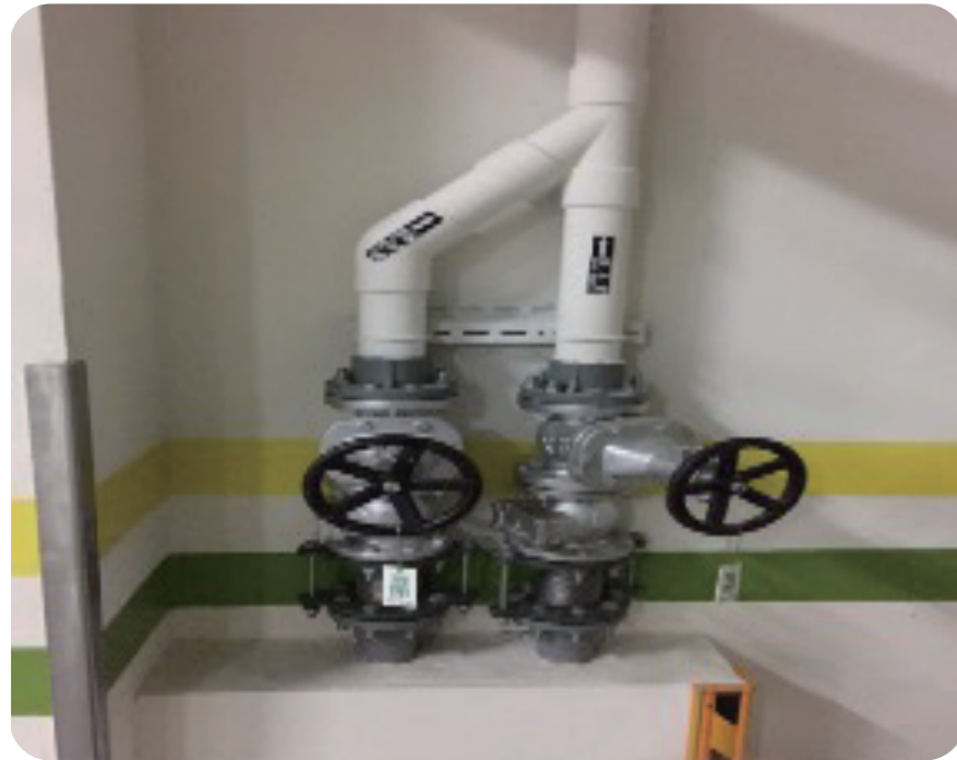
污水改善雨水管路獨立配置
